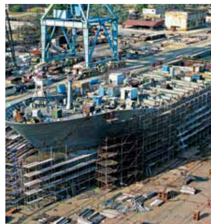
Cantiere navale - Terminal container
