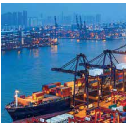
Cantiere navale - Terminal container
